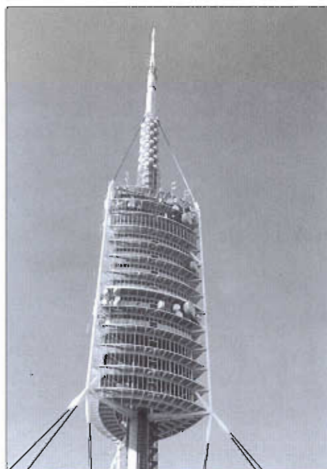
A l'esquerra, un centre emissor de TDT. Al costat, la torre de telecomunicacions de Collserola.
