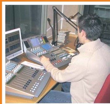
Control de Ràdio Manlleu, on hi ha instal·lada la consola AEQ BC 2000
